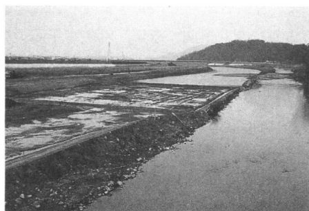
図1 河床土の掘削工事現場
