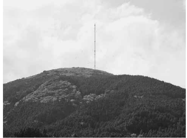
図1. はがね山標準電波送信所アンテナ（出所：情報通信研究機構HP）送信周波数：60kHzアンテナ施設：地上高200m傘型
